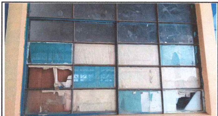
Foto 4: Sustitución de vidrios
