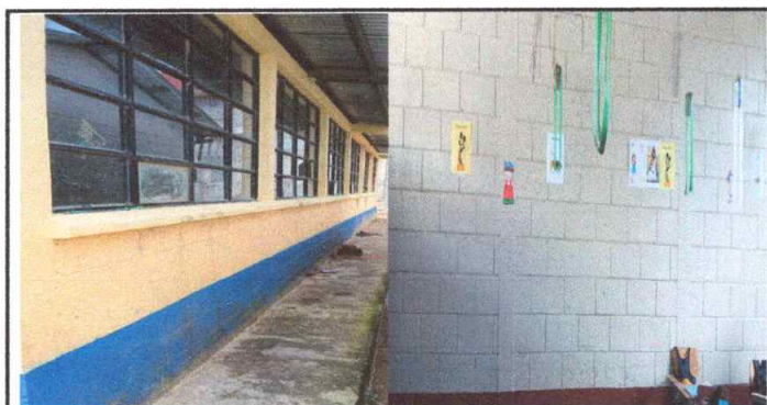
Foto 5: Pintura en muros exteriores e interiores
